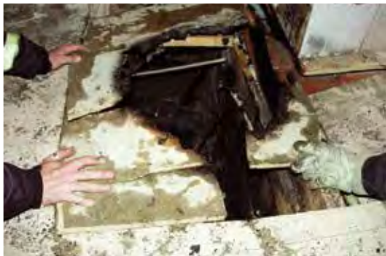
Felaktigt hanterad aska är en vanlig brandorsak. Här har golvet brunnit när aska från en kakelugn som det eldats i dagen före ställts i en plastpåse på golvet.
